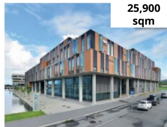
Kanalpiren - Hinna Park
