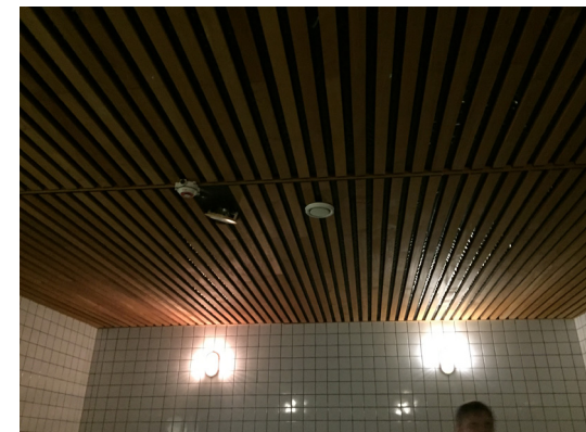
Wooden ceiling slats, Tøyenbadet sauna. Photo: Catriona Shine
